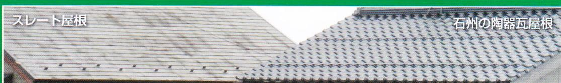
ほぼ同時期に建てられた、隣接するスレート屋根と石州の陶器瓦屋根(築15年程度/平成25年時点)
